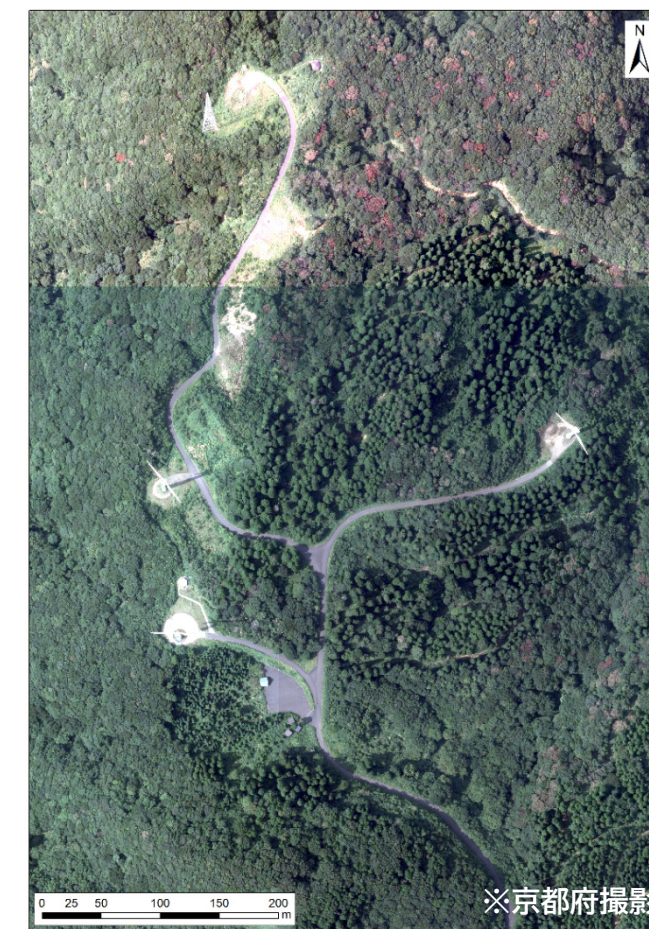
太鼓山風力発電所跡地（航空写真）
