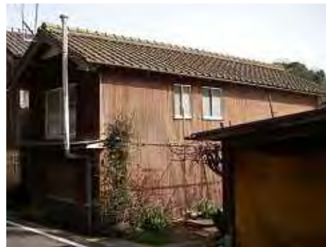
舟屋(道路側から)
