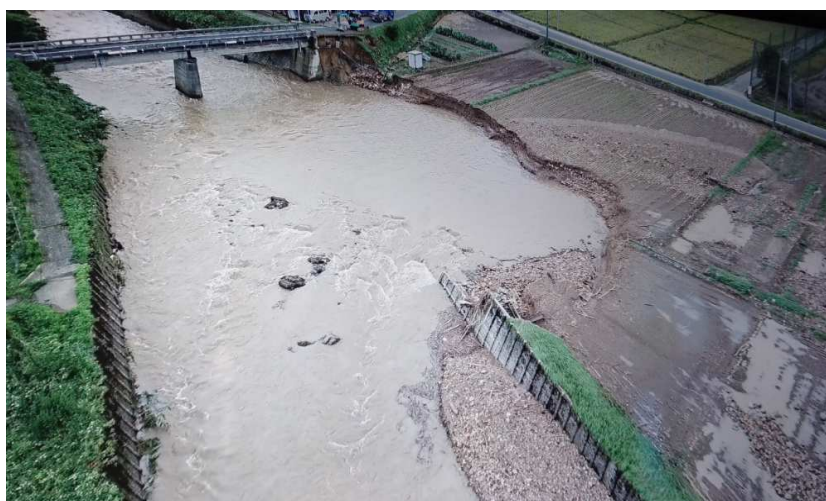
平成 29 年台風第 18 号 筒川被害状況
