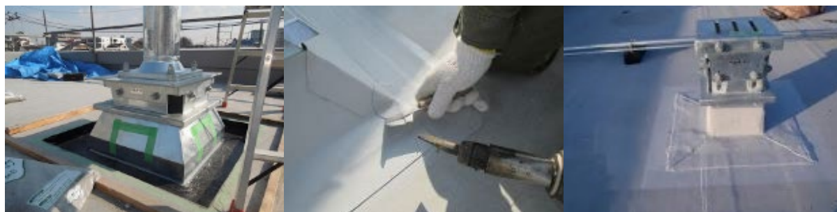
写真 2-4 堅牢かつ防水性の高い架台基礎の施工例
