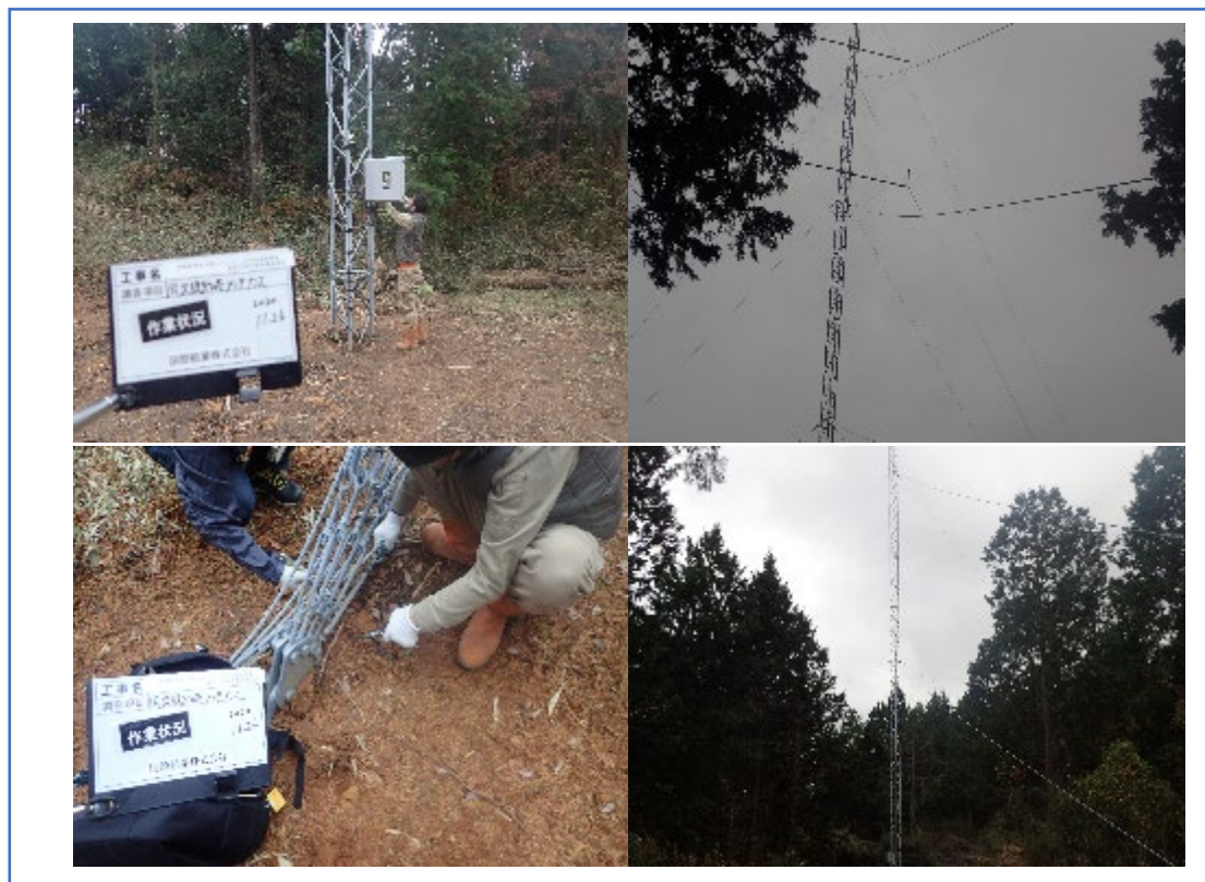
写真 4-3 点検作業の様子
