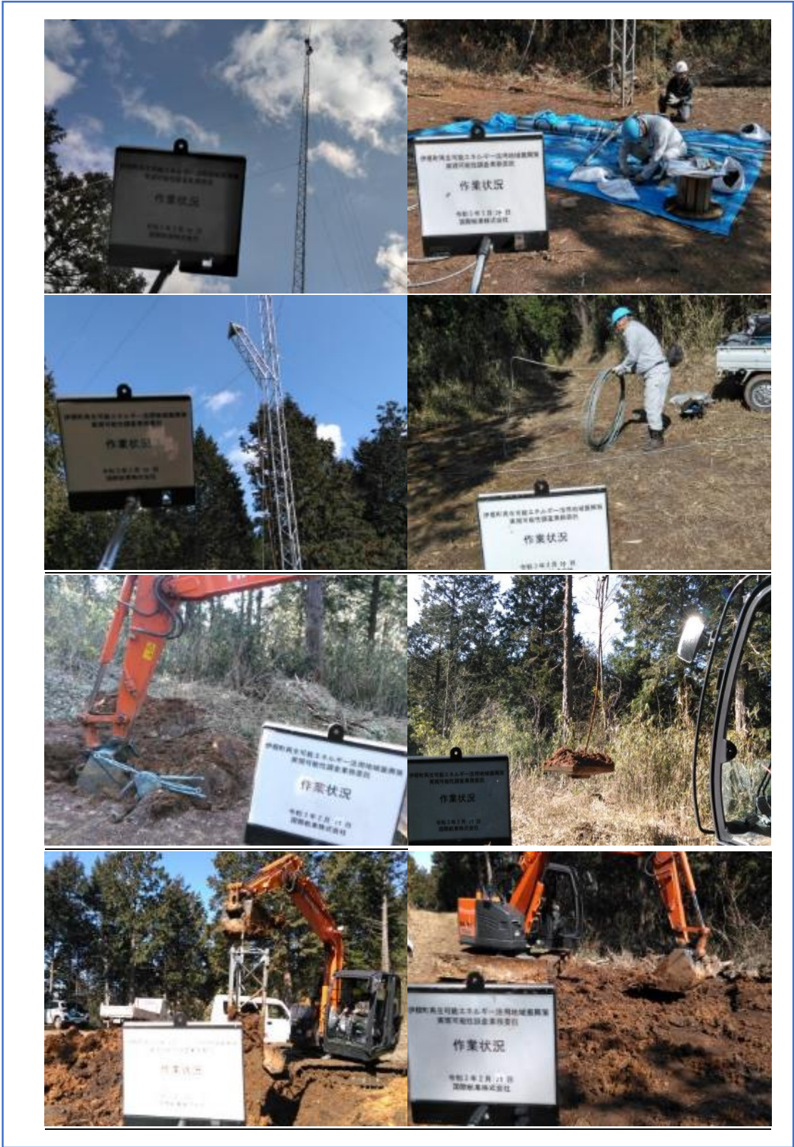
写真 4-4 撤去作業の様子
