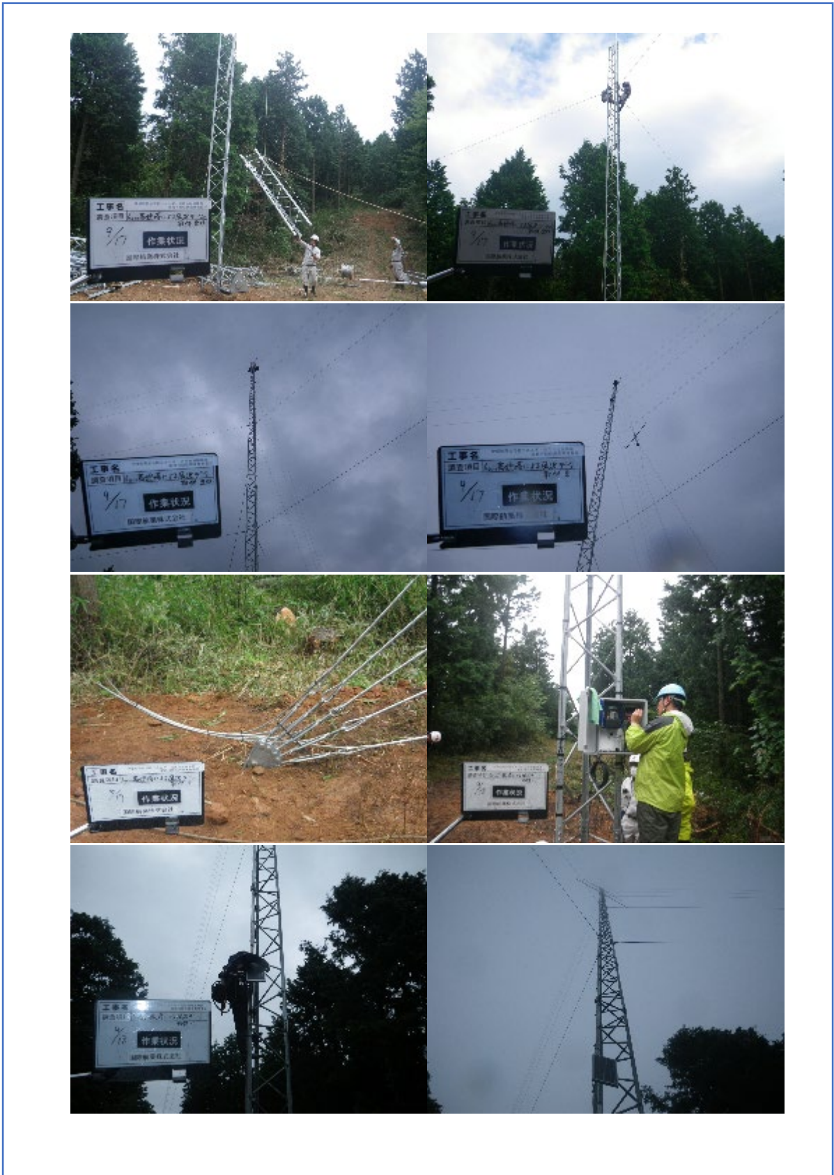
写真 4-2(3) 観測塔設置工事の様子
