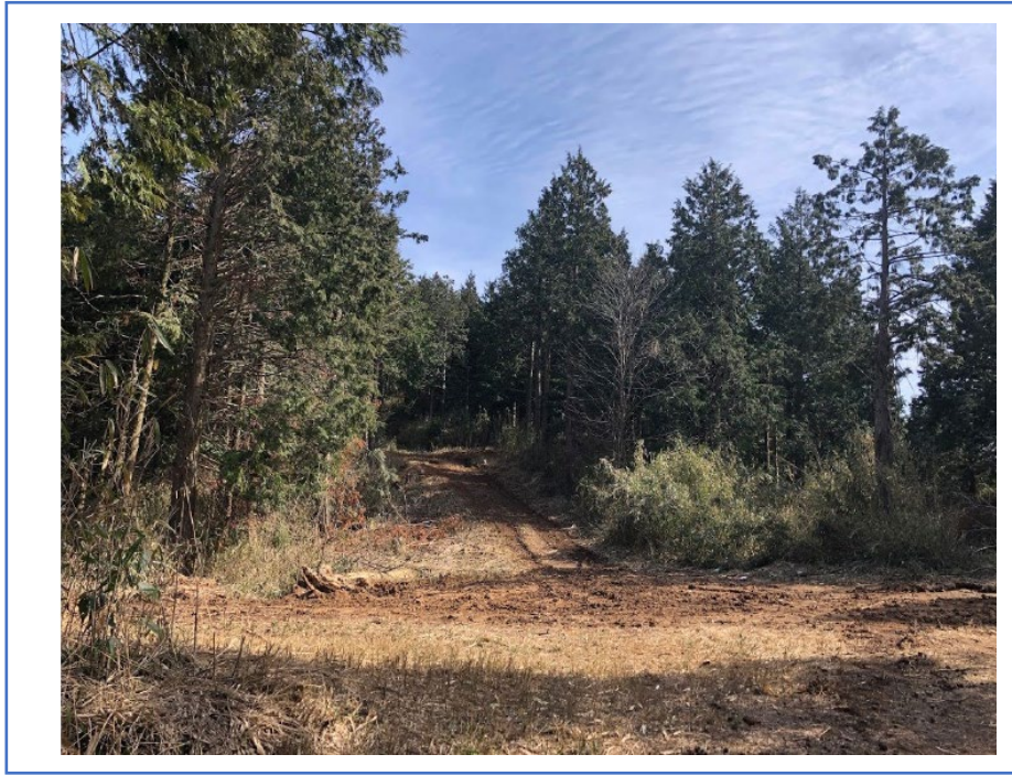
写真 4-5 撤去完了後の写真（全景）
