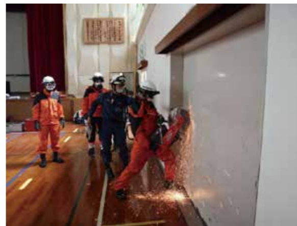
エンジンカッターでドアを切断している様子
