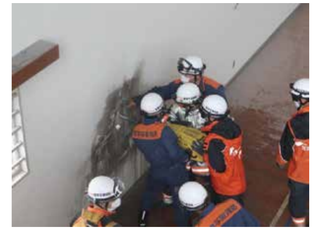
コブラコンビ(削岩機)で壁を破壊している様子
