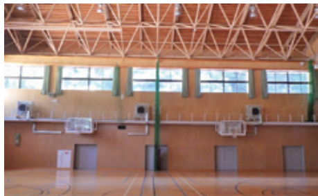
伊根中学校体育館に空調設備を設置しました。
