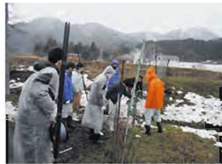
獣害フェンス設置
