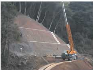
伊根中学校グラウンド拡張工事
