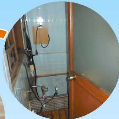
住宅改修助成事業 (施工前)
