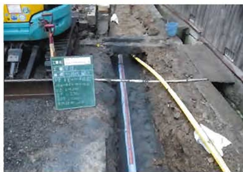
進む下水道工事
