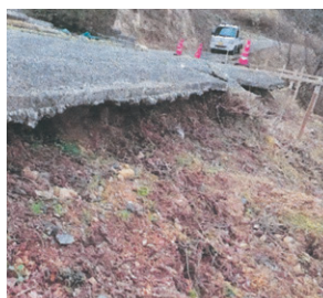
[改修される菅野地区墓参道]
