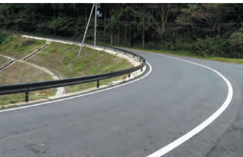
町道改良事業（野室～本庄浜線）
