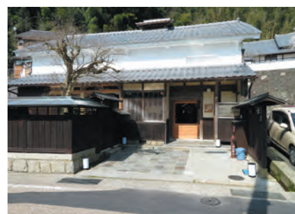
伊根町伝建物活用改修工事 (飲食施設)
