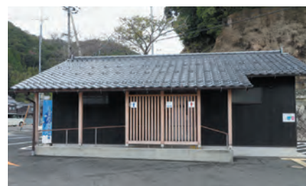
観光施設整備事業 (七面山トイレ)
