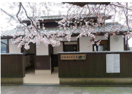
日出公衆トイレ
