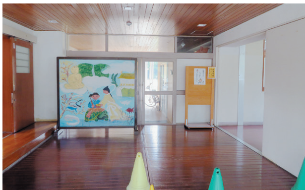
体育館との渡り廊下部の雨漏り修繕
