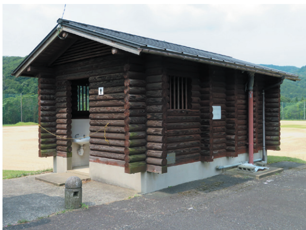
使用中止の桜ヶ丘運動公園公衆トイレ漏水修繕
