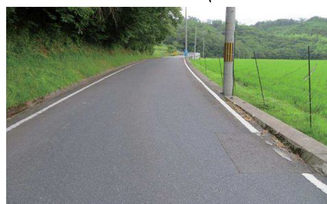
残土処分場への進入路
