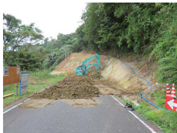
野室工事現場
