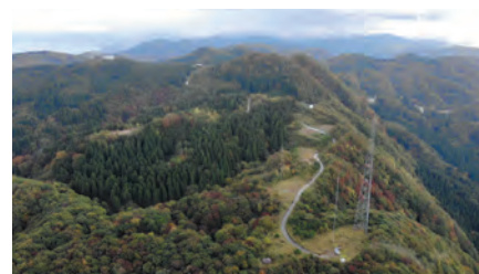
風力発電施設
