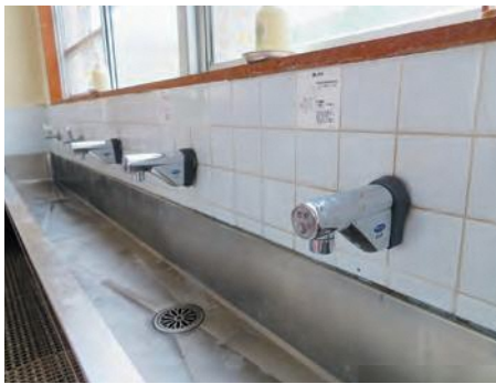
整備された自動水栓
